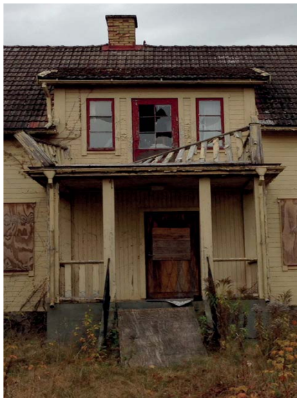
Förfallen byggnad. Foto: Anette Klang
